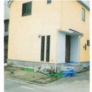
鋼管杭によって基礎補強された建物
